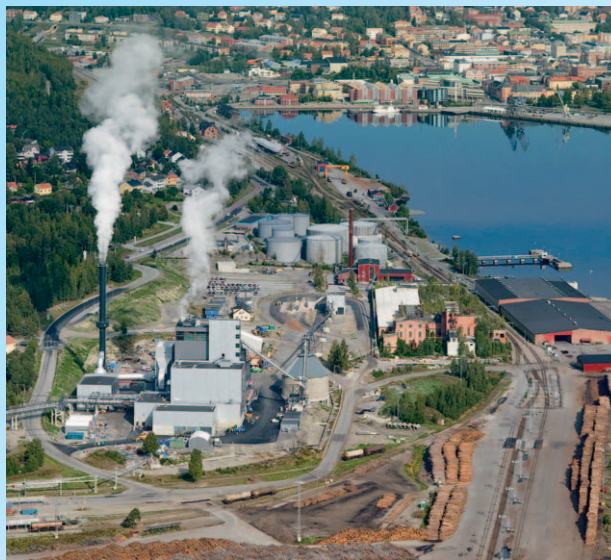
Det nya Hörneborgsverket sett från luften. FOTO: FOTOVERKSTAN
