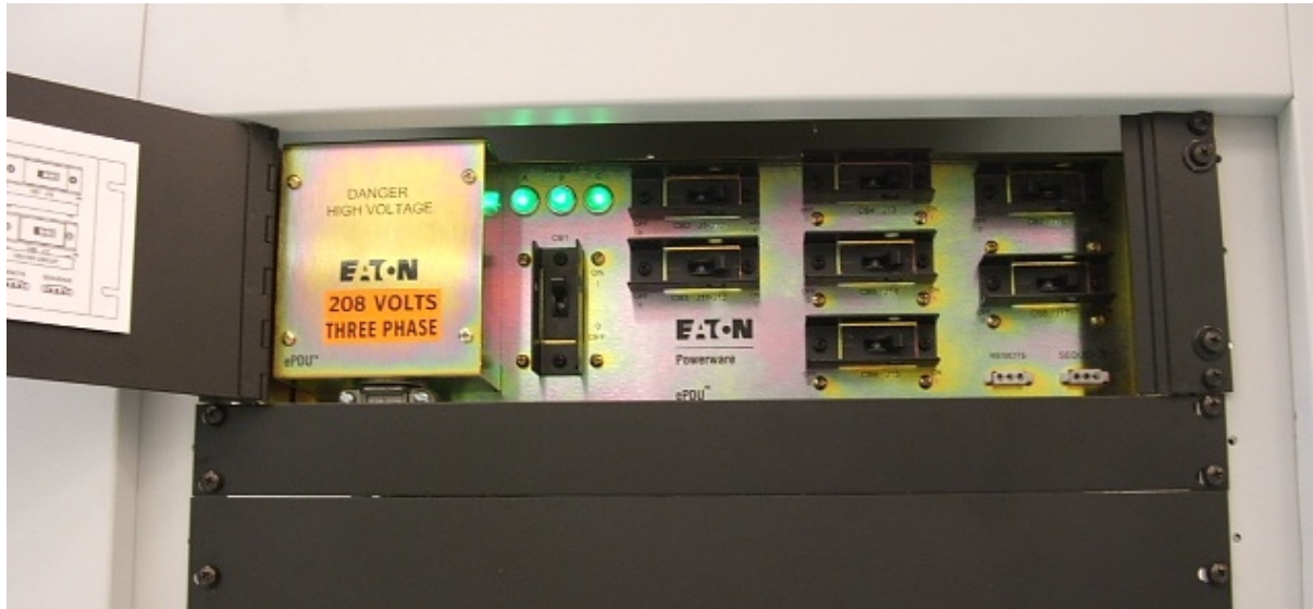
FIGURE 1: SYSTEM POWER DISTRIBUTION UNIT (PULIZI)
