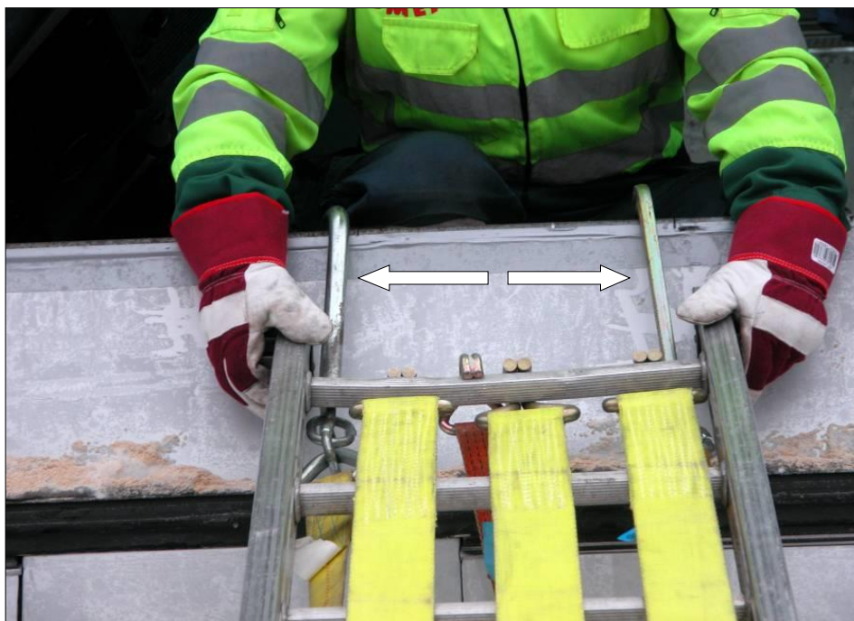
Figur 10.6. Stegens övre anläggningspunkt. Krokarna anläggs upptill för att förankra stegen i öppningen och på detta sätt underlätta evakueringen på bår.
