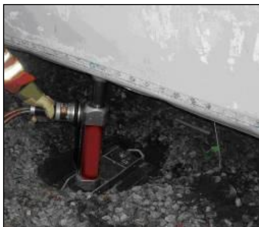
Figur 8.9. Lyft med en kort hydraulcylinder. Genom att applicera en kort hydraulcylinder mot takets långsida kan lyftet snabbt påbörjas. De stabilaste punkterna är där stolparna ansluter.
