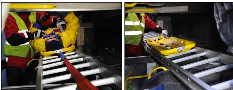
Figur 10.12. Man kan evakuera de skadade genom att låta baren glida på stolarnas sidor mot mittgången, eller ännu hellre, glida på en skarvstege för att slutligen passera ut genom framrutan. Då måste dörren till förarutrymmet först ha borttagits. Bandet som man kan dra ut den drabbade med är applicerat runt den drabbades bröstorg.
