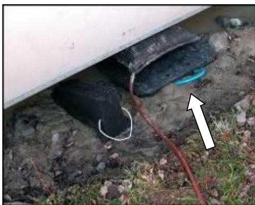
Figur 8.10. Vetterkuddar® kan användas till ”förlyft” för att sedan lättare få in en hydraulcylinder.
