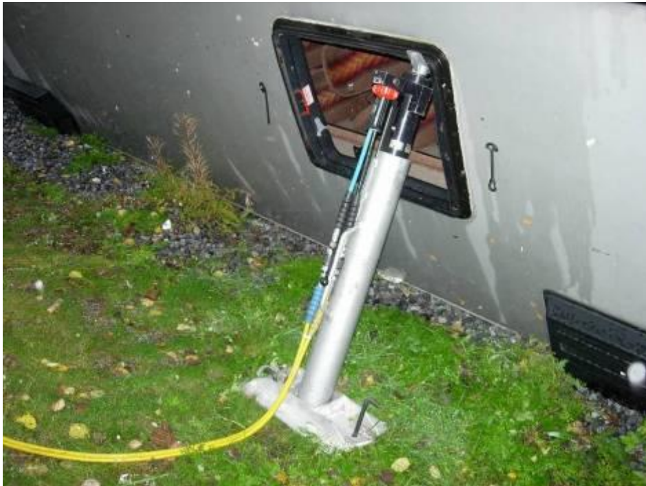
Figur 8.7. En mothållsplatta med förankringsspikar förhindrar att hydraulcylindrarna glider eller sjunker ner i marken.
