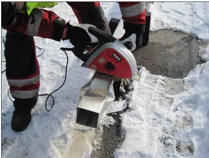
Figur 7.2. Cirkelsåg med klinga avsedd för användning i rostfritt stål rekommenderas för att ta sig igenom rostfria plåtar och balkar. Smärgeltrissa eller tigersåg kan vara ett alternativ på borstål.
