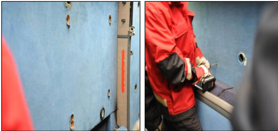
Figur 10.14. Man märker ut var hålet i golvet ska tas upp genom att borra i "hörnen" för att därefter såga upp ett rymligt hål mellan borrhålen.
