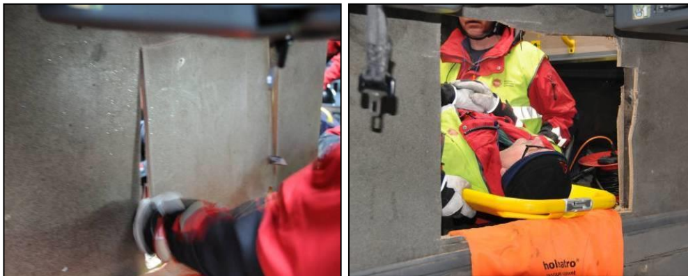
Figur 10.15. Luckan sågas upp, men den sega beläggningen på golvet i övervåningen kan kleta igen sågklingan.
