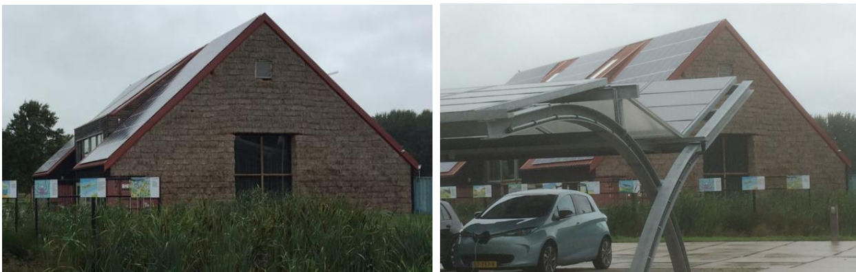
The Energy Barn, och carport med solceller för laddning av elbilar (Foto tv: Lars Lindbergh)
